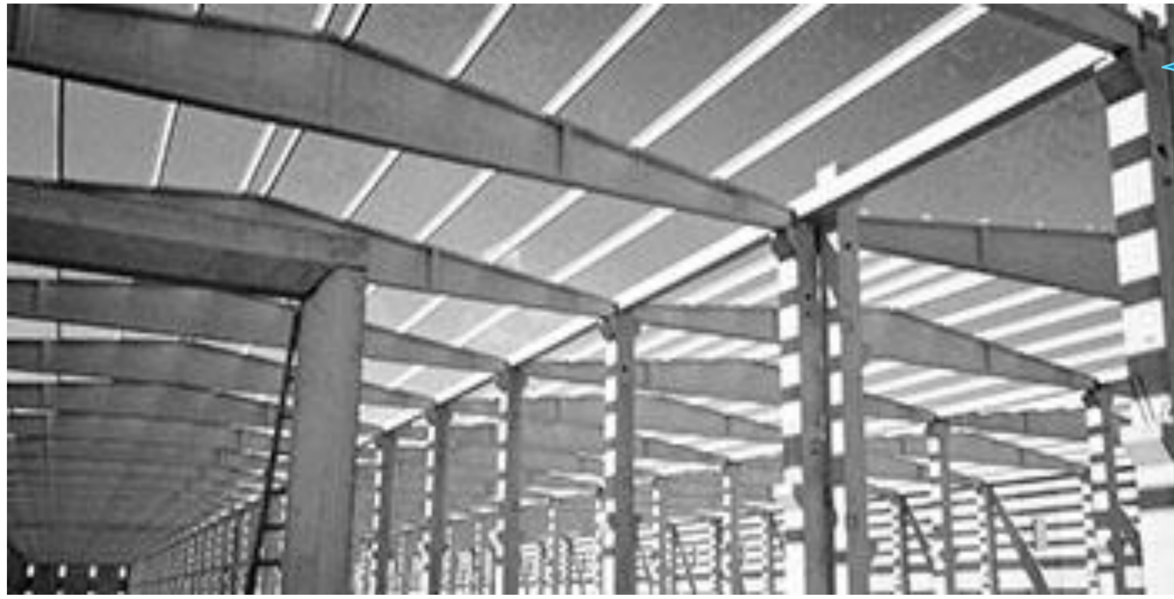
Şekil 1: Önüretimli Prefabrik Yapı
