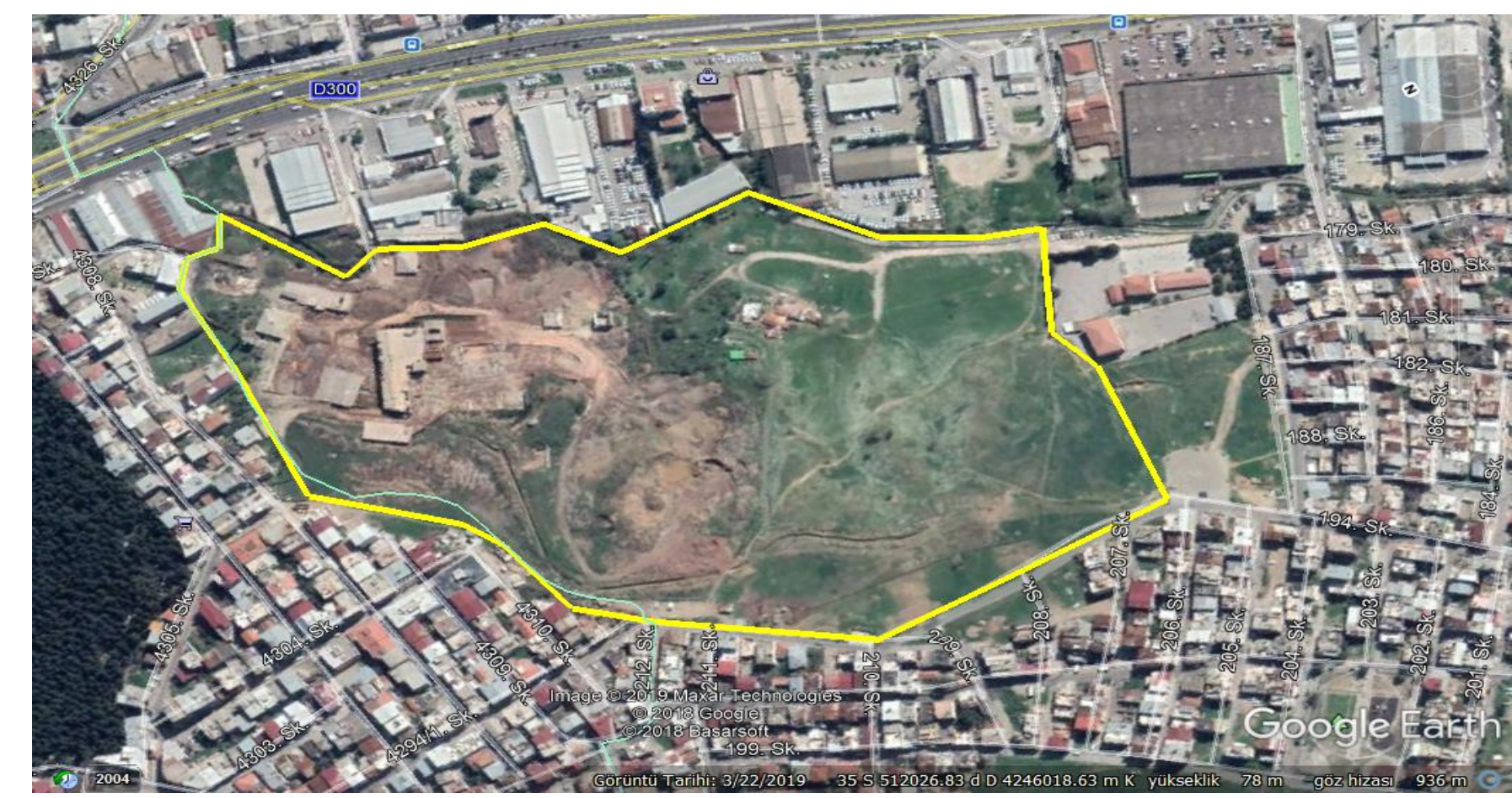
Şekil 2. İkinci çalışma sahası olan Gaziemir akü üretim fabrikası.
