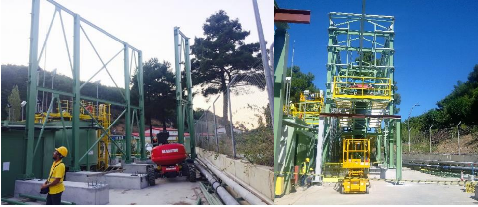
Şekil 40. Filtrasyon Binası Montajı
